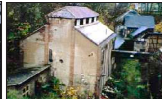
Heizhaus (Vorbereitende Untersuchung 1998)
