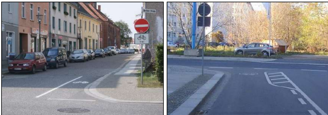
Abb. 43 Einfahrhilfen im Einmündungsbereich freigegebener Einbahnstraßen
