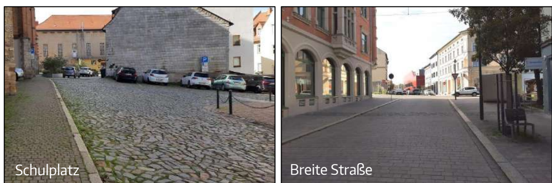
Abb. 16 Beispiele Pflasteroberflächen im Innenstadtbereich
