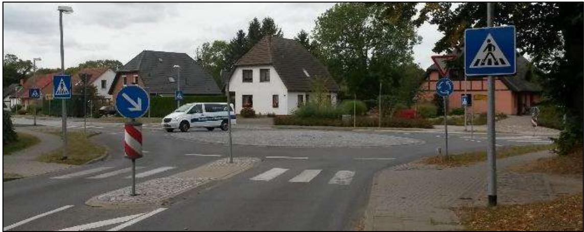
Abb. 48 Beispiel für die Gestaltung von Minikreisverkehren
