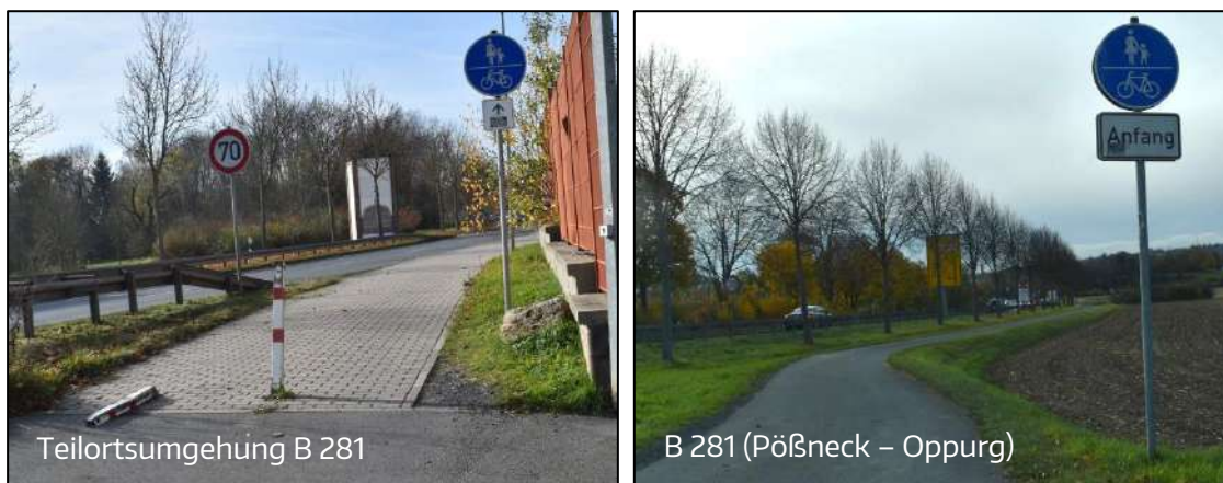
Abb. 2 Bestandssituation benutzungspflichtige Geh- und Radwege
