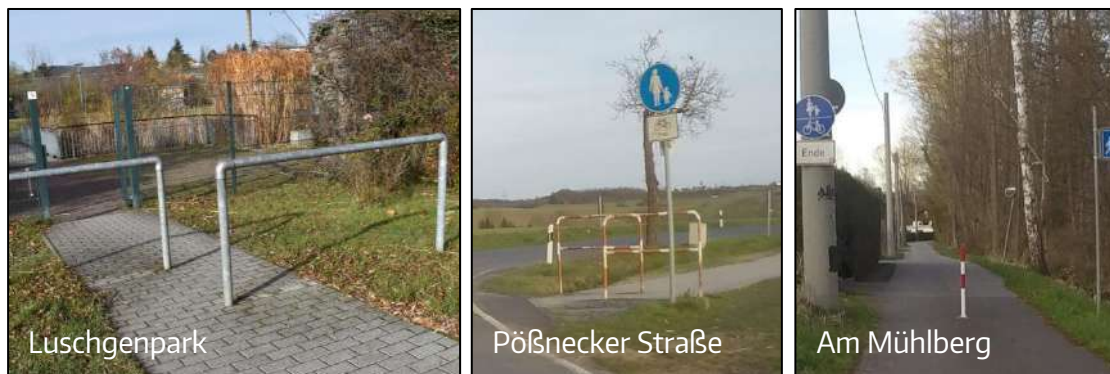
Abb. 14 Beispiele für Poller und Umlaufsperrn im Stadtgebiet
