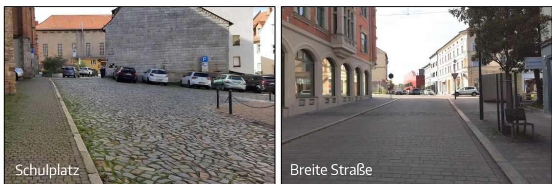
Abb. 16 Beispiele Pflasteroberflächen im Innenstadtbereich
