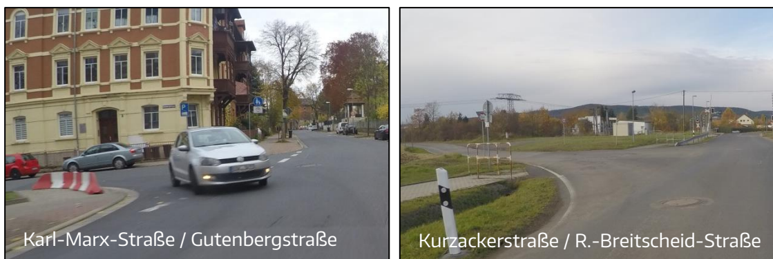
Abb. 6 Bestandssituation Radverkehrsführung in Einmündungsbereichen
