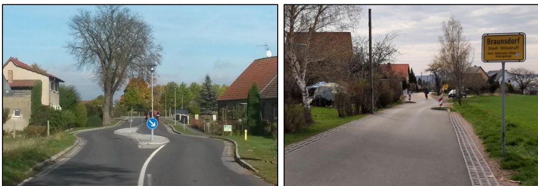
Abb. 53 Beispiele Ortseingangsgestaltung mit Fahrstreifenversatz bzw. Fahrbahneinengung
