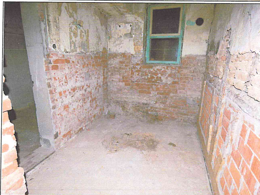
Bild 8: Nebenraum im EG
