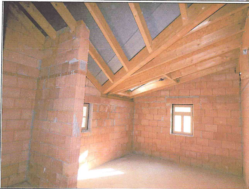
Bild 11: Raum im 1. OG, niedrigerer Gebäude- teil
