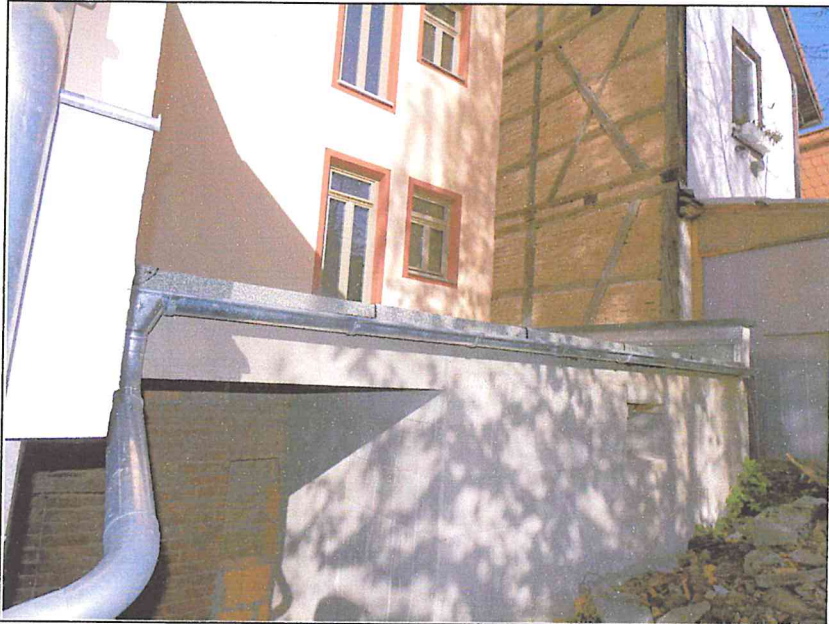
Bild 4: wie vor, eingeschossiger Gebäudeteil, Erdgeschoss
