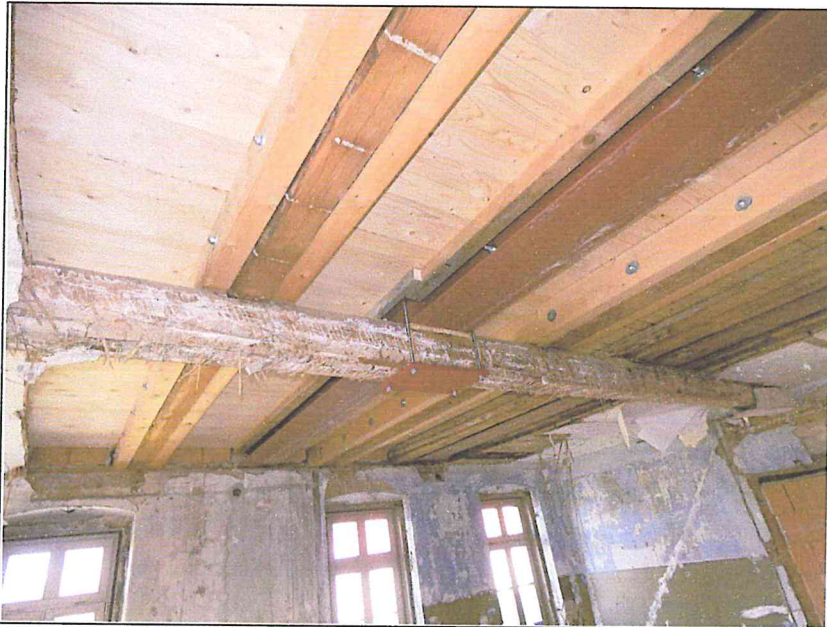
Bild 10: teilerneuerter Deckenbereich im OG
