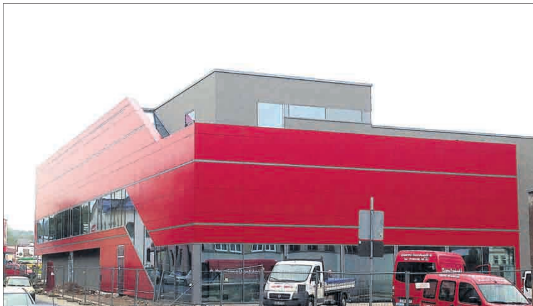
Außenansicht des neuen Stadtbades, Fotos (3): Andreas Dreißel.
